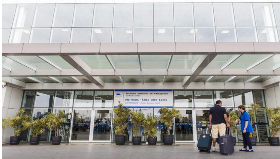
Figura 9: Terminal de Passageiros
