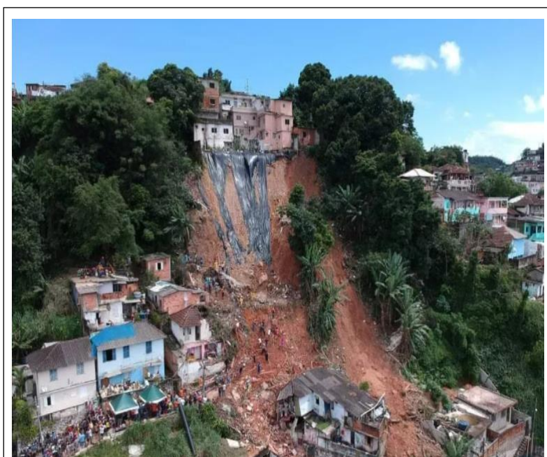
Figura 14 – Deslizamento no Morro São Bento - Santos/SP
