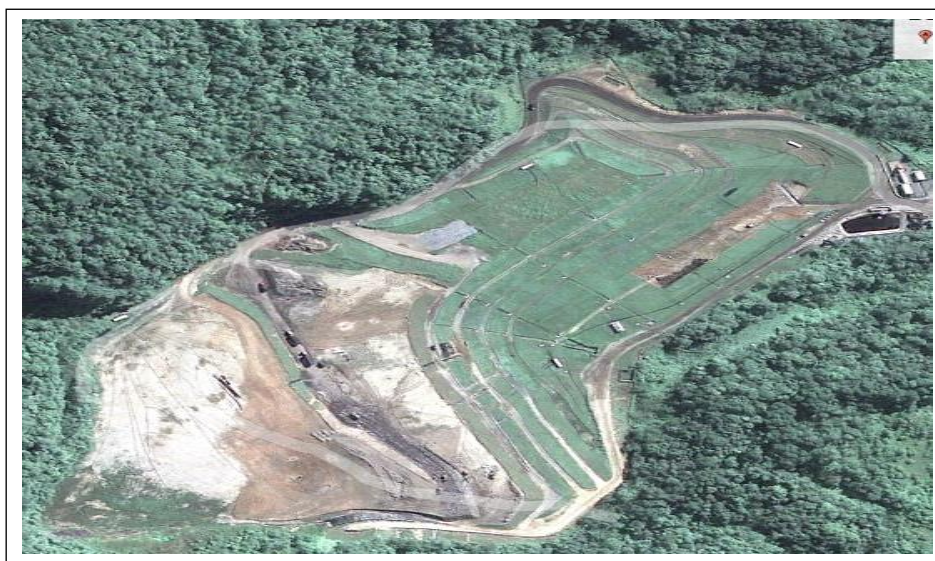
Figura 28 – Imagens aéreas: Aterro sanitário Sítio das Neves - Santos/SP - 2009
